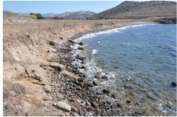
Resim 4. Batı Limanı Kıyı Hattı Yapı Temellerinden Görünüm.
