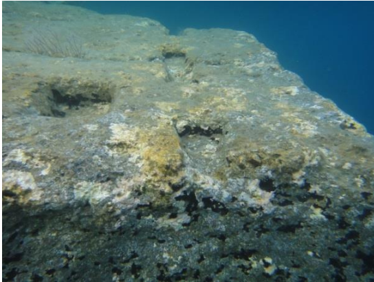
Resim 10. Kırlangıç Kuyruğu Kenet Yuvası.
